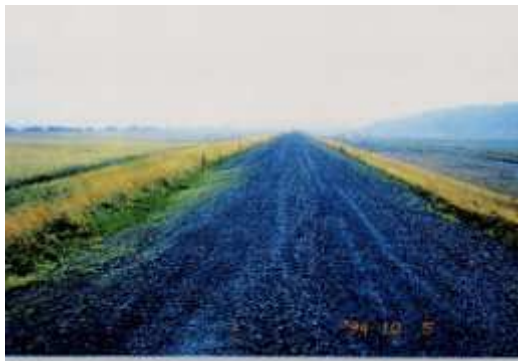
写真 2.2 北海道東方沖地震後の盛土状況（対策有）
