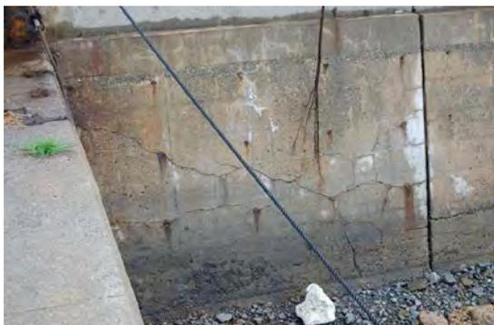
写真-1 防波堤に生じたひび割れ
