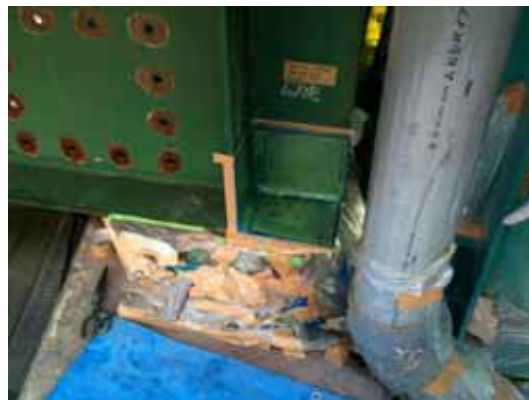
(d) After repair
