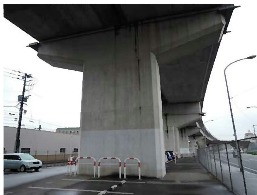
(b) 施工完了（薄灰部が施工範囲）
