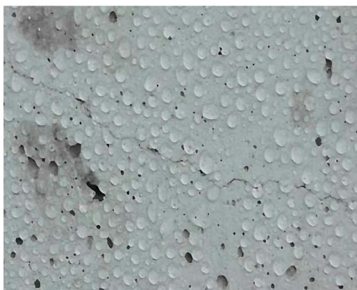
(c) 撥水状況（塗布部）
