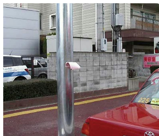
写真-1.1 貼紙剥離状況 1)
