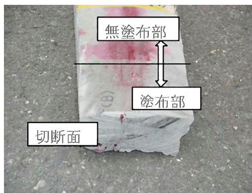
(c) 切断後の状況（手前が塗布部の切断面）
