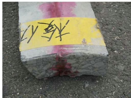
(d) 切断後の状況（無塗布部）
