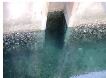
写真-2 ゲートでの海洋生物着例<sup>2)</sup>
